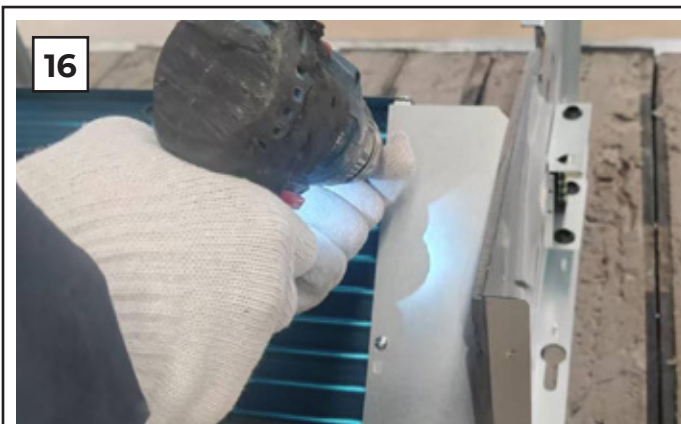
Открутите винты крепления боковых панелей, рис. 14-15
