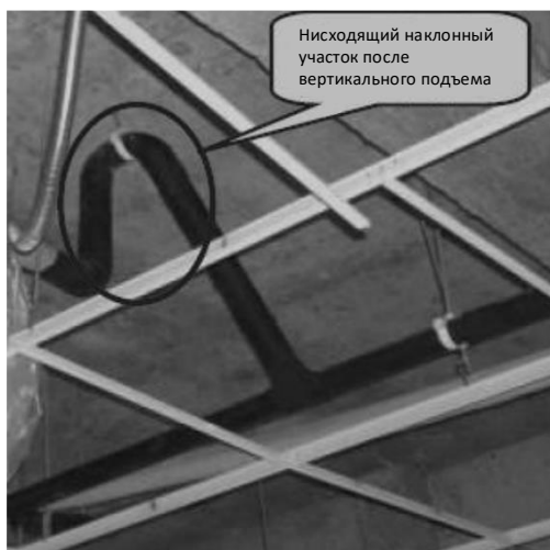
Рисунок 3-6.7. Нисходящий наклонный участок дренажного трубопровода
