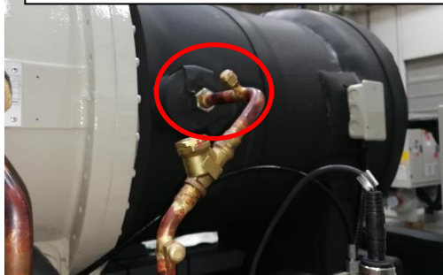
Напорное отверстие кожуха двигателя
